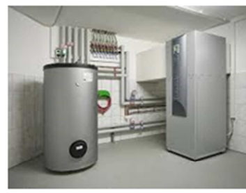
Elektro-Wärmepumpe
